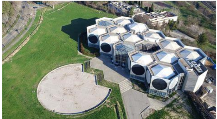
Fondation Vasarely inaugurée en 1974 par Georges Pompidou, Jacques Chirac et Guy Michel (Aix en Provence)
